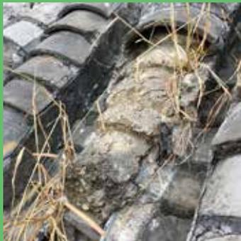
接缝处漏水
