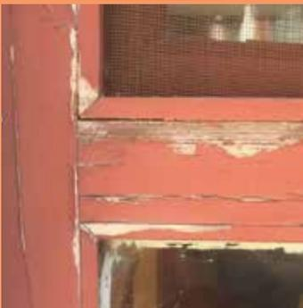
外部木材保护问题 油漆脱落 剥落
